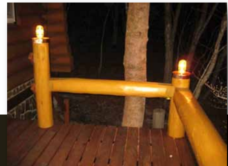
完成したデッキ
